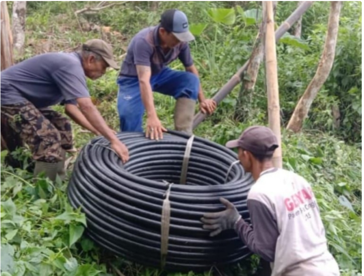
Progres pekerjaan pompa hidram pertanian Desa Panji Anom
